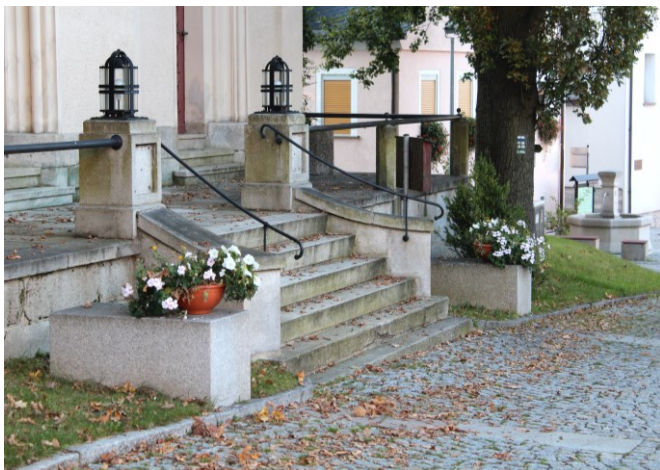
Treppenaufgang zur Kirche von Bad Brambach.
